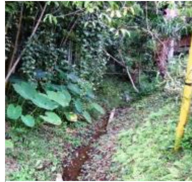
西念寺裏の隧道出口
