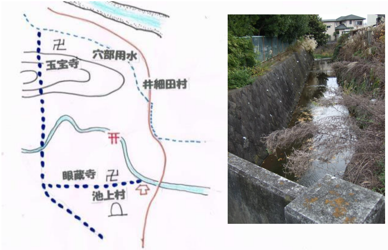
【写真は眼蔵寺前の水路。「そらし水門」で水路の先は山王川である】
